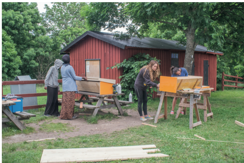
Sommarjobbare bygger topplistikupor. Eggeby gård 2015.
